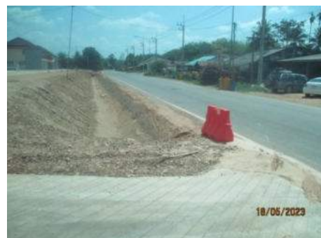
รูปที่ 2-5 รางระบายน้ำบริเวณพื้นที่ก่อสร้าง
